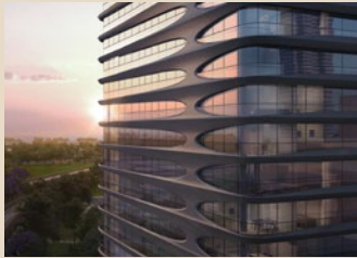
L'AVENUE LIBERTADOR M2 de construcción: 42.110 m 2
